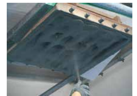
●鉄筋背面への充填性試験
